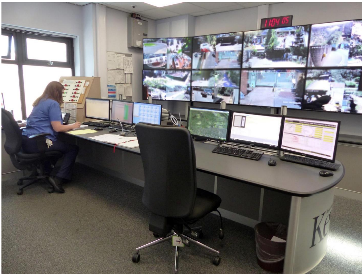
Рисунок. Типичное помещение видеомониторной комнаты
